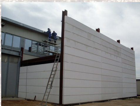
Tamponamento a resistenza termica e REI 180
