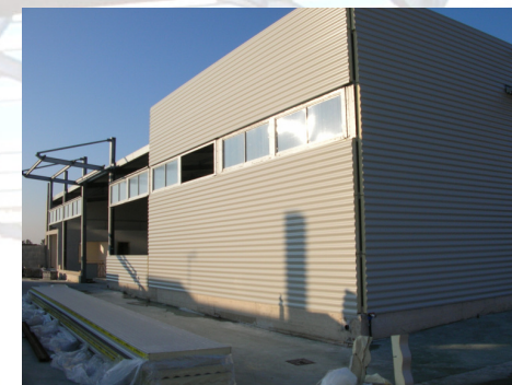
Edificio industriale con struttura in acciaio e pannelli coibentati.
