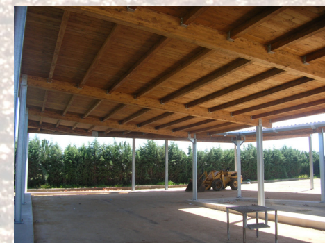
Copertura legno lamellare ed acciaio
